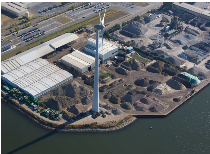
Vaste Soilwash installatie op het grondrecyclagecentrum | © DEME group
